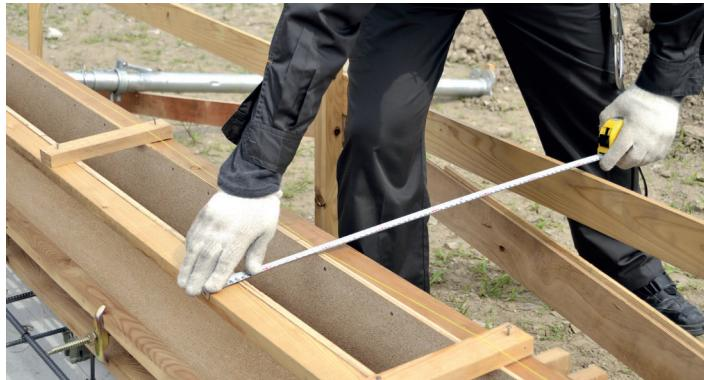
Duripanel je pogodan za izradu izgubljene oplate. Zadržava konstruktivnost i u slučaju direktnog izlaganja vodi.
